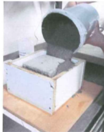
Preparazione del provino : colaggio del REFOR-tec ® nell'intercapedine 30 mm tra il cubetto cls e la cassaforma
