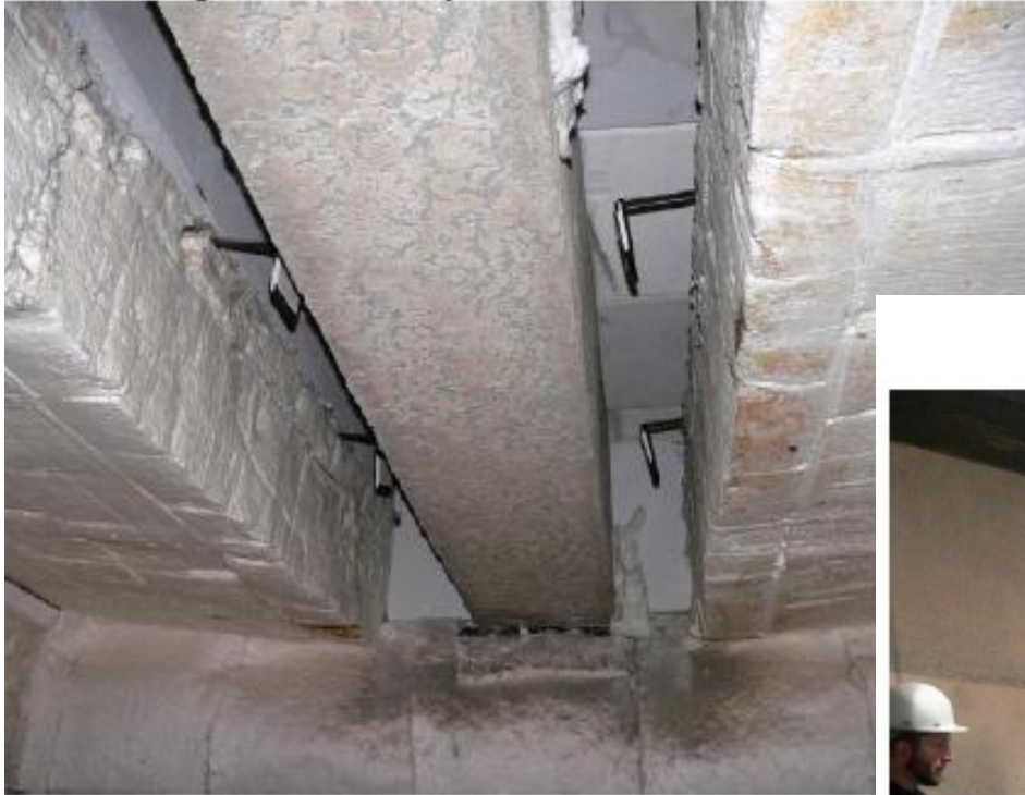
Figure 1 : Face exposée au feu avant essai
