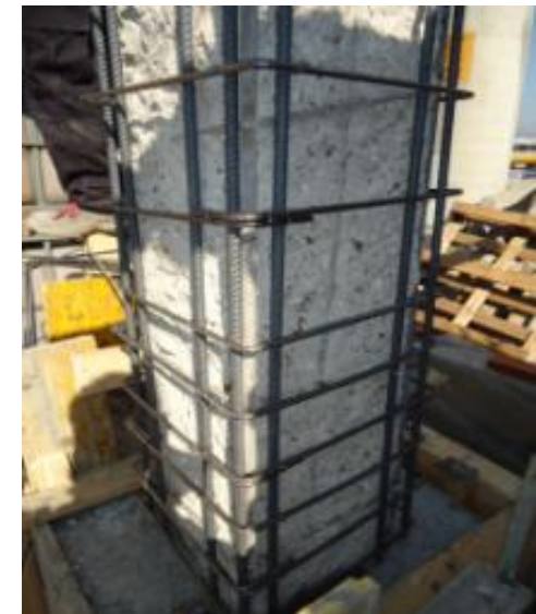
con armatura aggiunta dopo scarifica
