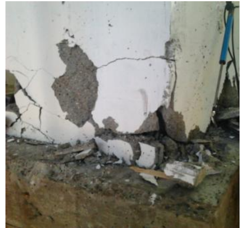
Fessurazioni e crepe evidenti con principio di "spalling" !
