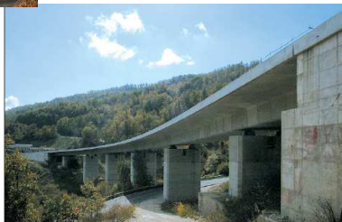
Viadotto S.S. Isernia Castel di Sangro (AQ)
