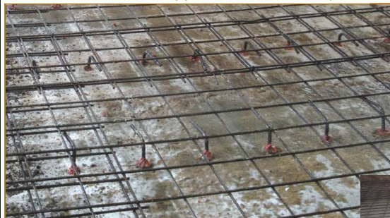
Connettore non industrializzato (tipo sistema "Turrini-Piazza")
