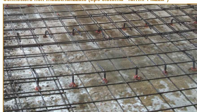
Connettore non industrializzato (tipo sistema "Turrini-Piazza")
