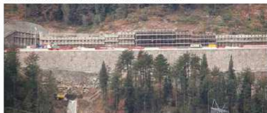
Autostrada A1 Variante di Valico: Rilevati leggeri in "Terra Armata"
