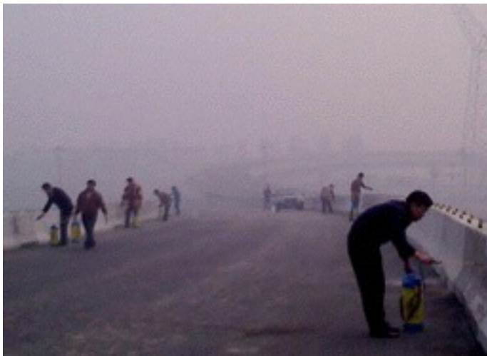
Applicazione sui parapetti in calcestruzzo
