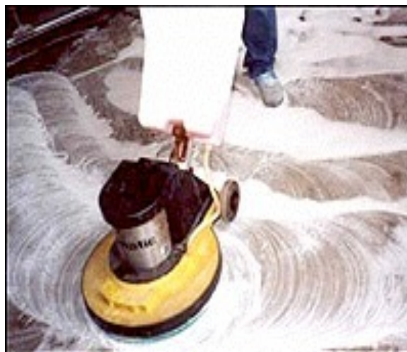
Pulizia di una superficie in calcestruzzo con Deep Clean 250
