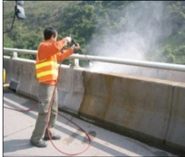
Rimozione dell'emulsione Deep Clean 250
