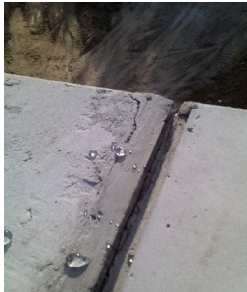
Dopo il trattamento con i sigillanti DPS e TS di Evercem
