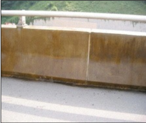
Trattamento del parapetto di un'autostrada con Deep Clean 250
