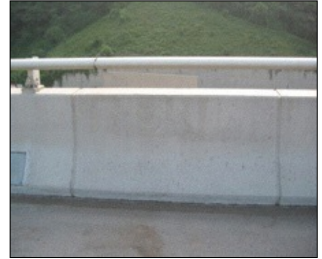
Parapetto in calcestruzzo pulito
