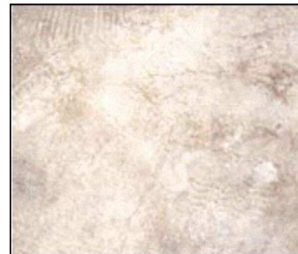
Superficie in calcestruzzo pulita
