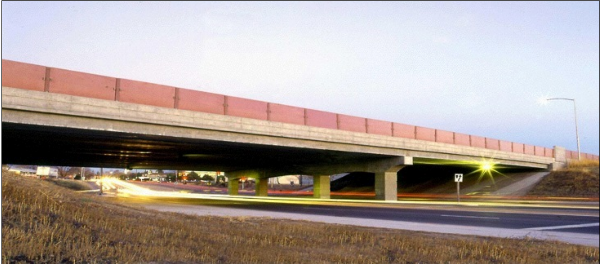
Ponte e piano viabile del ponte, Canada
