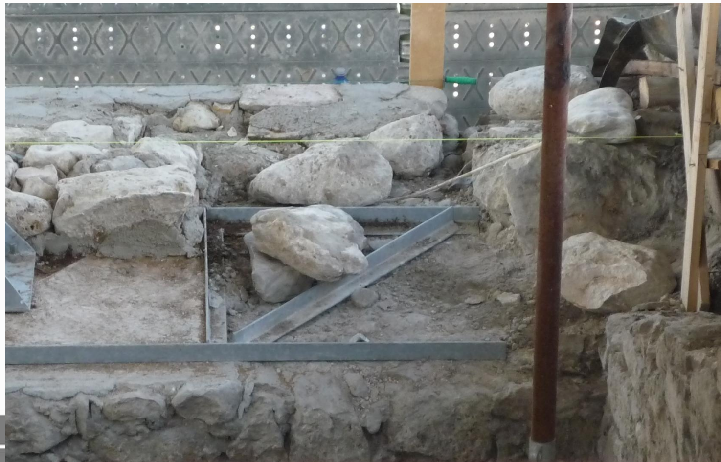
Traliccio in acciaio in sommità alla muratura
